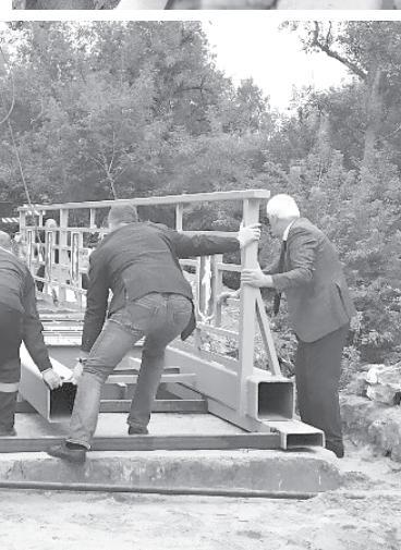
везли к опорам и, поддерживая краном, на металлических трубах прикатили на основание. Теперь будет смонтирована сварная конструкция, которая послужит креплением для кирпичных опор как снаружи, так и внутри, и тем самым убережет существующие опоры от разрушения. И, как мы уже писали, основная нагрузка будет идти не на них, а на металлические сваи, которые заводчане забурят на глубину 2 метра не доходя до этих опор. Само покрытие вымостят брусчаткой и смон-
