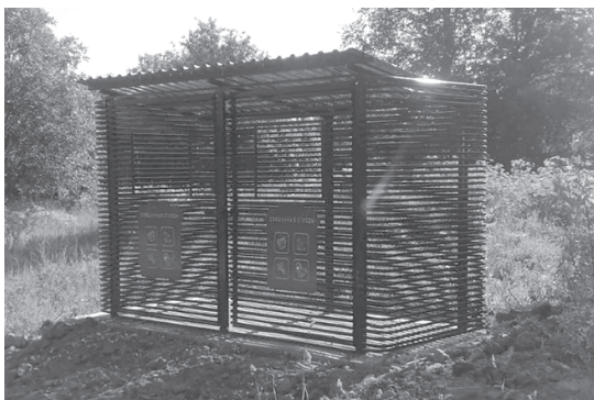
Контейнерная площадка в Домашино
