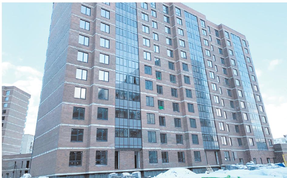
ЖК «Космос» в Москве: семь 12-этажных зданий из кирпича VOLGABRICK
